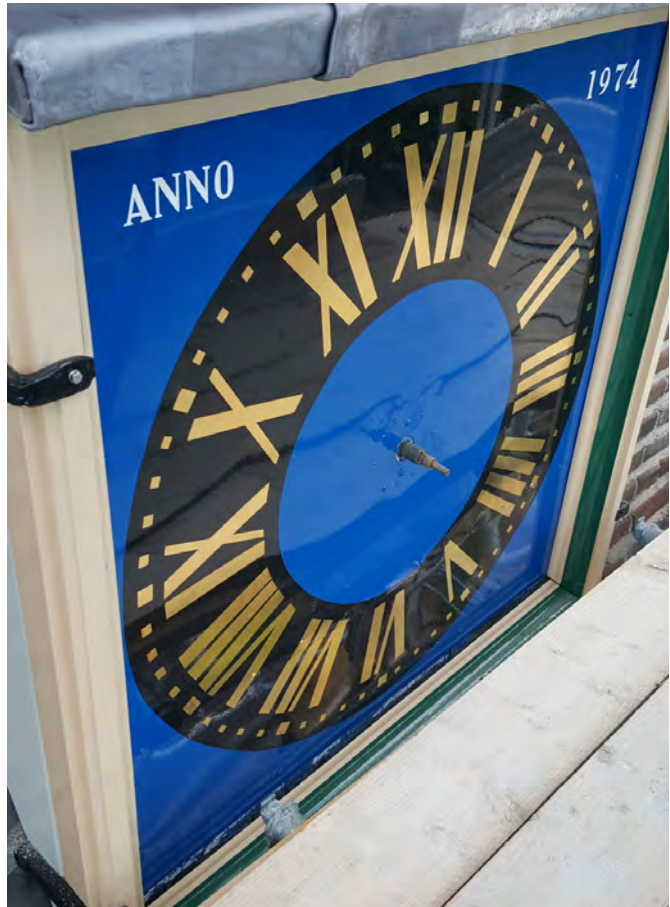
Wijzerplaat westzijde tijdens renovatie in 2021
